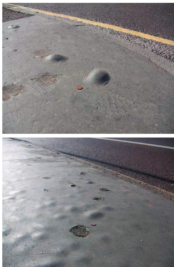
図5 加熱サイクル作用によるアスファルトの膨脹
